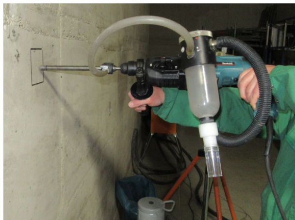
Figure 7: Drill dust sampling (EWN Entsorgungswerk für Nuklearanlagen GmbH, Greifswald nuclear power plant)
