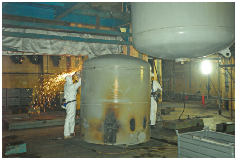
Figure 8: Dismantling and disassembly of containers (EWN Entsorgungswerk für Nuklearanlagen GmbH, Greifswald nuclear power plant)
