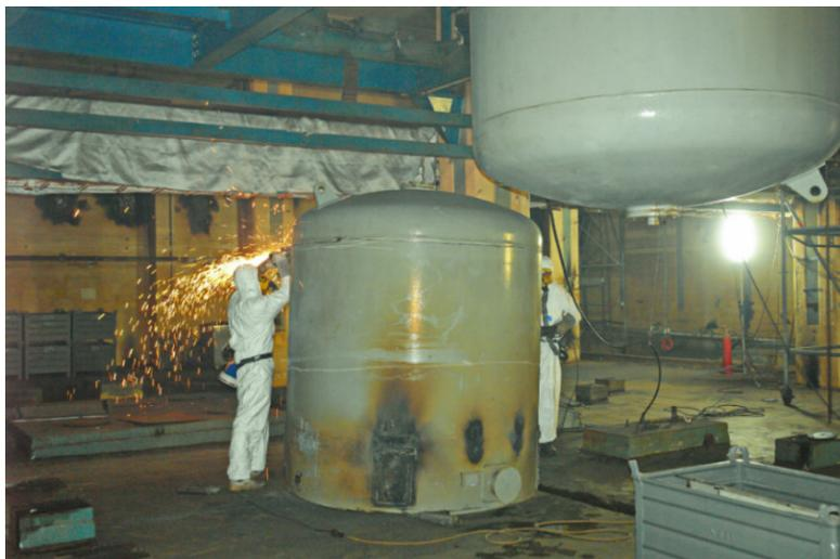
Abbildung 8: Abbau und Zerlegung von Behältern
